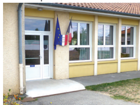
Mise en conformité de l'accessibilité
