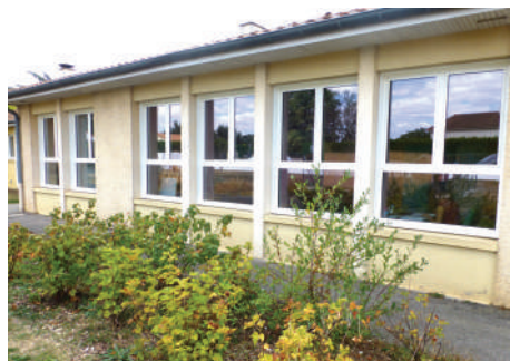
Remplacement des huisseries
